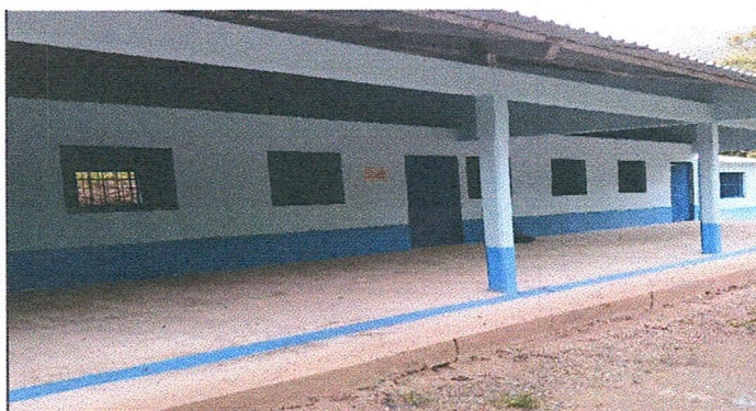
Foto 3: Vista del area en donde se instalaron las puertas y balcones completos.
