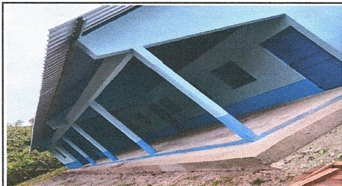
Foto 1: Vista el trabajo del pasillo se trabajó completamente.
