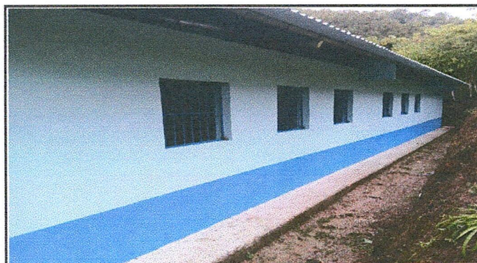
Foto 4: Vistas en perfil del modulo ya pintado.
