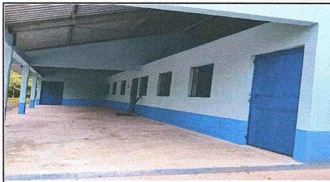
Foto 2: Ya se instalaron las tres puertas.
