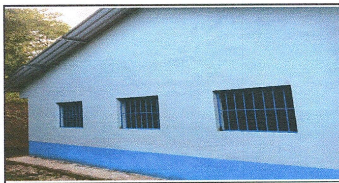
Foto 5: Fondo Superior ya fue pintada y colocado los balcones.
